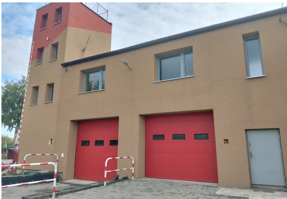
Budynek przy ul. Reymonta – po pracach remontowych
