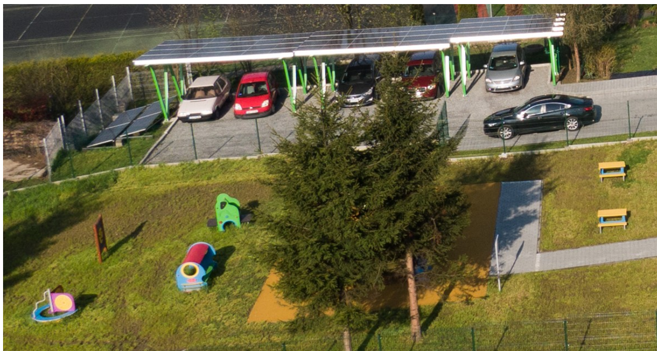
Na pierwszym planie plac zabaw przy żłobku. W tle parking zadaszony panelami fotowoltaicznymi, które produkują energię na potrzeby placówki.
