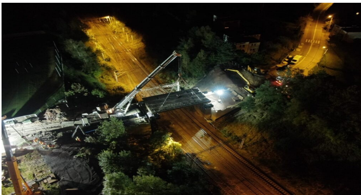
Budowa wiaduktu w Radlinie. Stan z dnia 16.12.2020 – montaż belek nośnych
