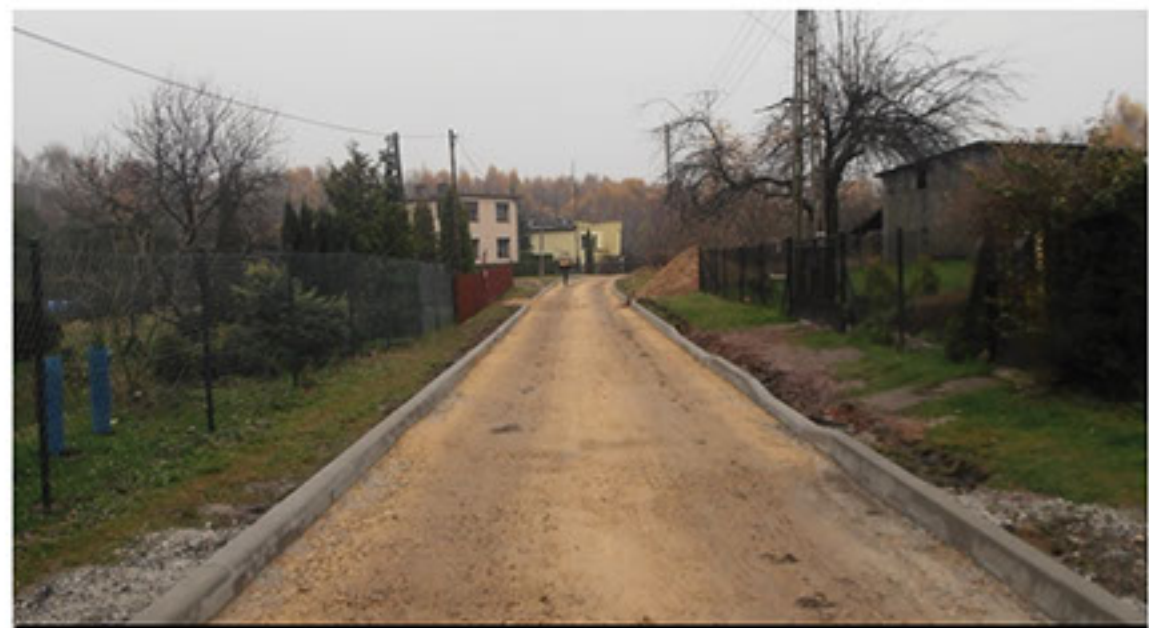
Prace trwają. Ul Napierskiego. Listopad 2013
