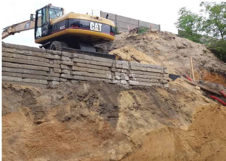
Ilustracja 4: Prace rozbiórkowe na wiadukcie przy ul. Mariackiej w Radlinie.
