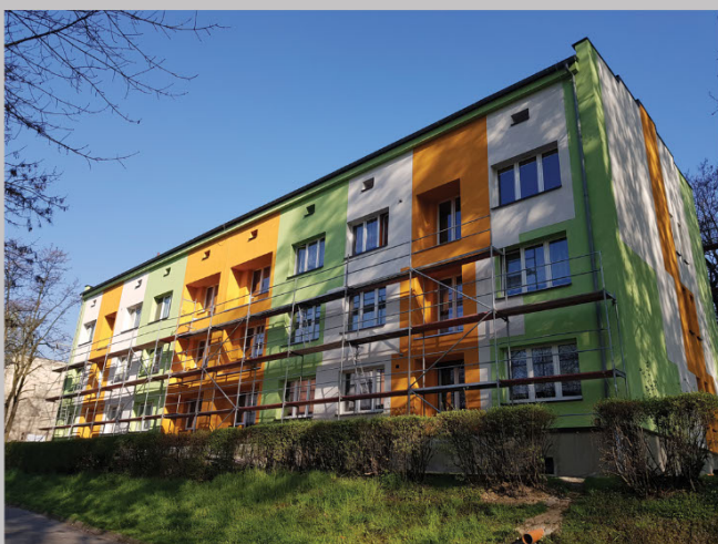
Termomodernizacja budynków przy ulicy Mikołajczyka
