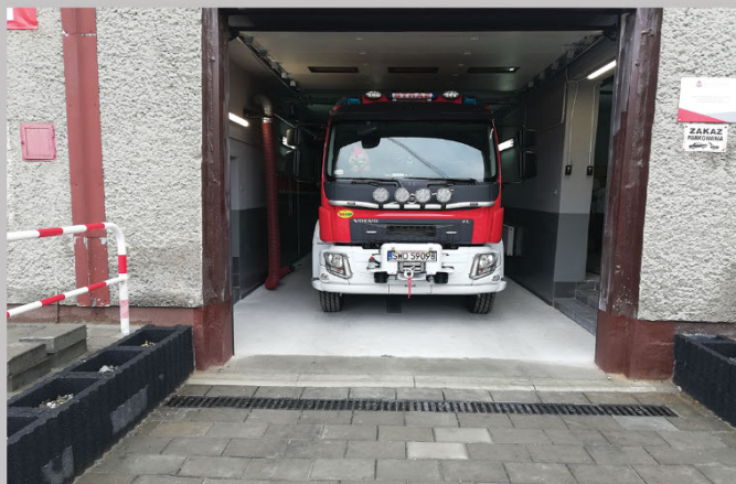
Przebudowa garażu przy OSP Głożyny
