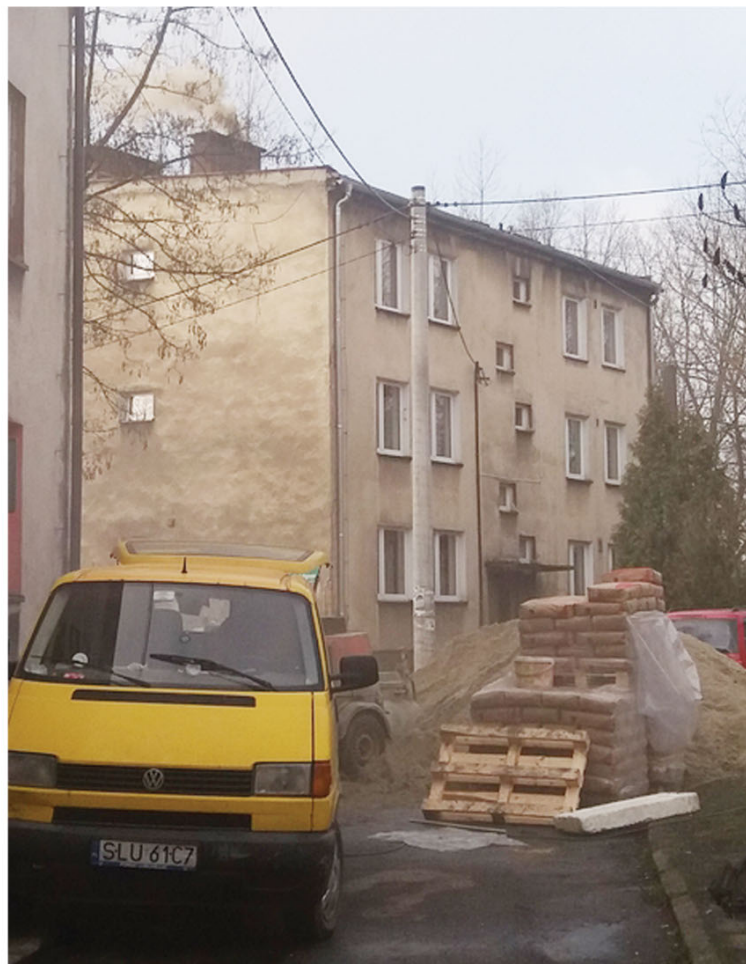
Termomodernizacja kolejnych budynków na ul. Mikołajczyka
