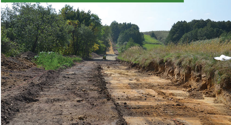
Budowa ścieżki rowerowej do Wodzisławia Śl.
