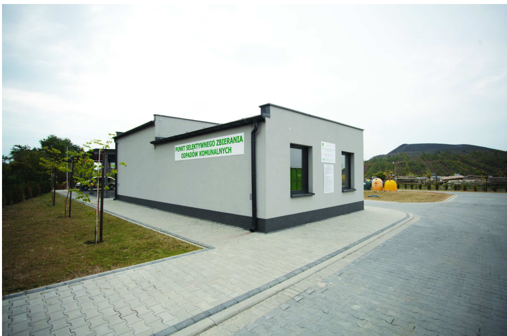
Fot.1. Uruchomiony we wrześniu 2015 r. Punkt Selektywnego Zbierania Odpadów Komunalnych (PSZOK)
