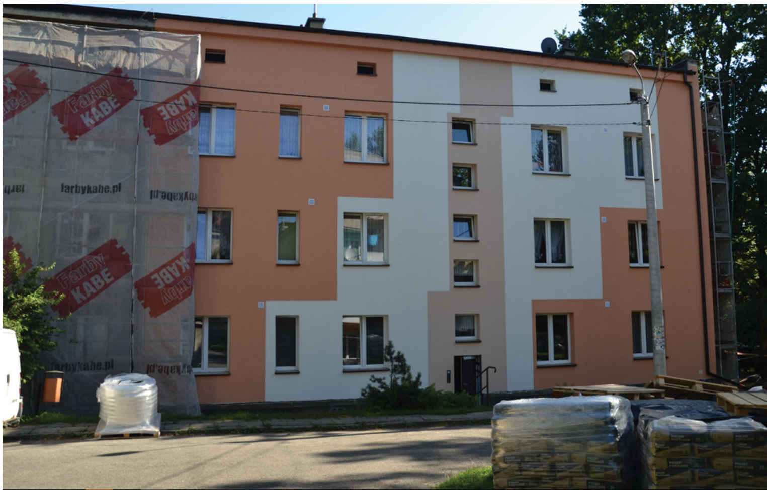
Na fotografii: prace termomodernizacyjne na osiedlu przy ul. Mikołajczyka w 2017 roku
