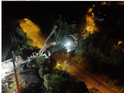
Budowa wiaduktu w Radlinie
