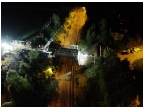
Budowa wiaduktu w Radlinie
