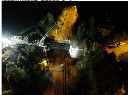
Budowa wiaduktu w Radlinie
