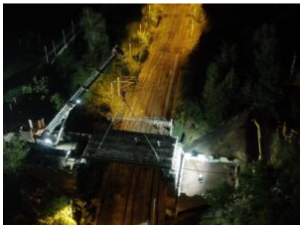
Budowa wiaduktu w Radlinie
