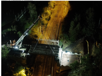
Budowa wiaduktu w Radlinie
