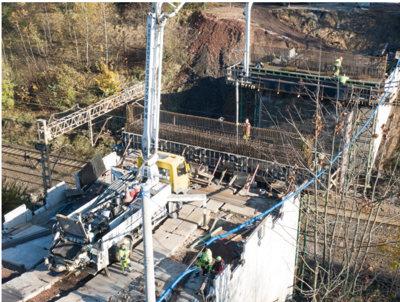
Budowa wiaduktu – listopad 2020
